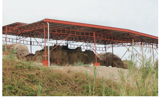
Res. 7 15. yy. sur duvarlarının koruma önlemleri
